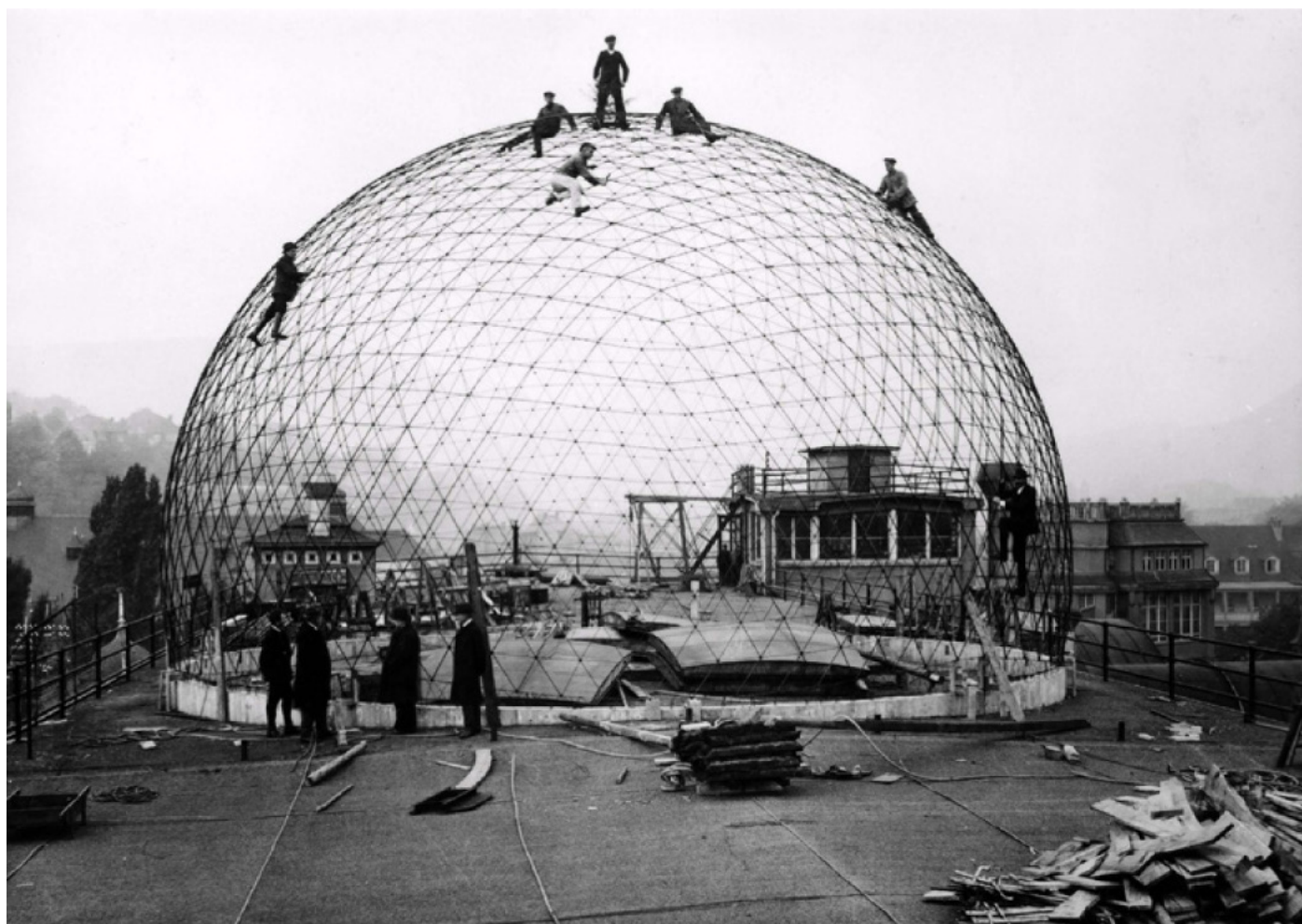
Planétarium Zeiss en construction sur le toit de l'usine © Zeiss Archives
