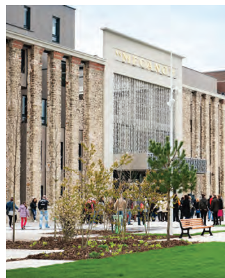
La Courneuve - Usine Mecano © Virginie Salot- Ville de la Courneuve
